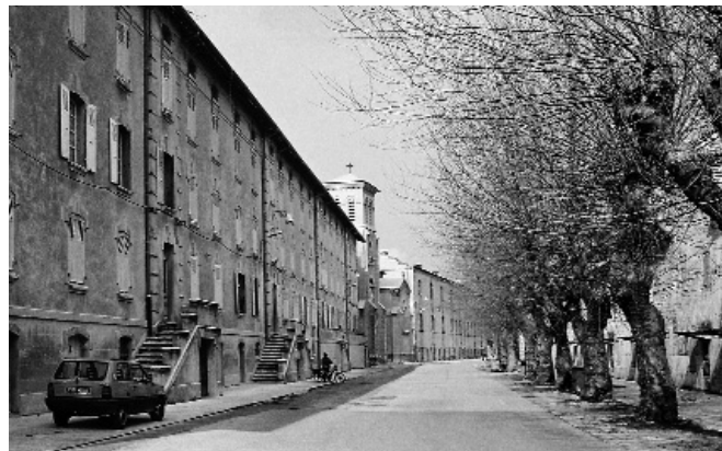
Cité Blanche - logements de 1913, église et sacherie
