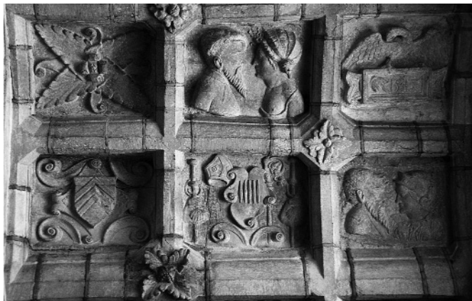
Plafond à caissons de la chapelle Senecterre
