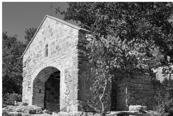
... et après travaux.
