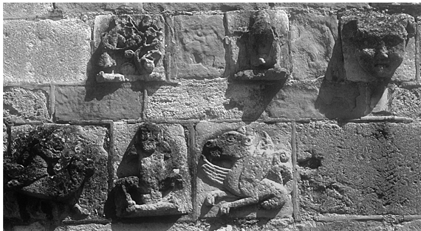
Église de Champagne : emplois sur la façade.
