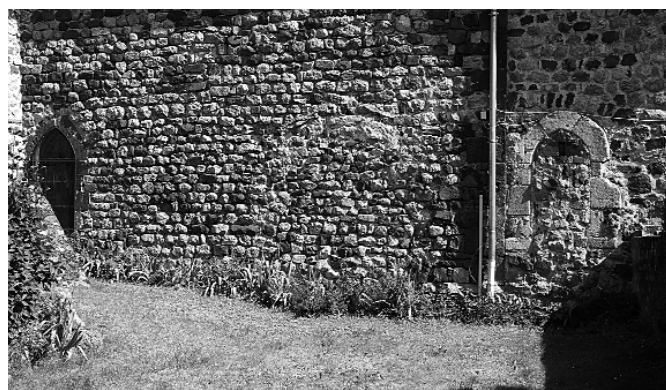
Mur ancien, fermant le Clos à l'est, réemployé dans la construction de l'église paroissiale au XIX e siècle
