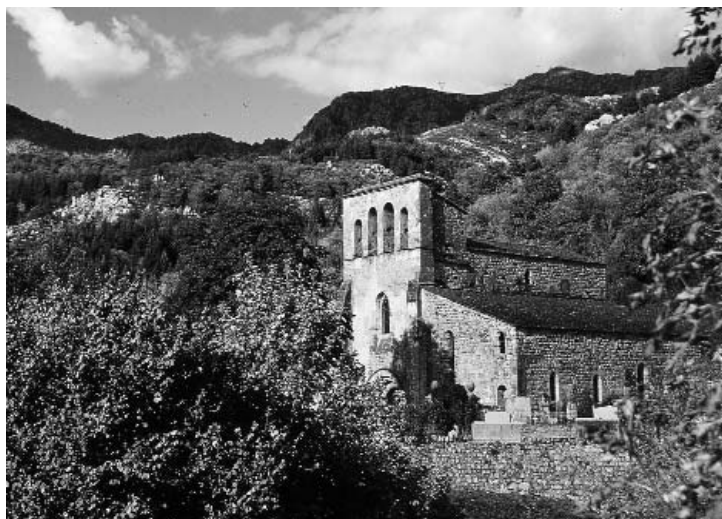
L'ancienne église N.-D. de Prévencières à Montpezat est l'objet de travaux de restauration avec notamment le concours de la Sauvegarde.
