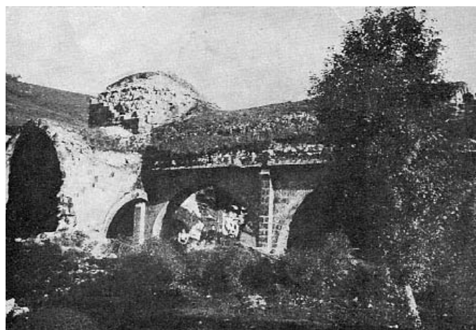
L'abbaye de Mazan à la fin du XIX e siècle, avant même le dynamitage de sa voûte (1905), avait déjà largement servi de carrière de pierres.
