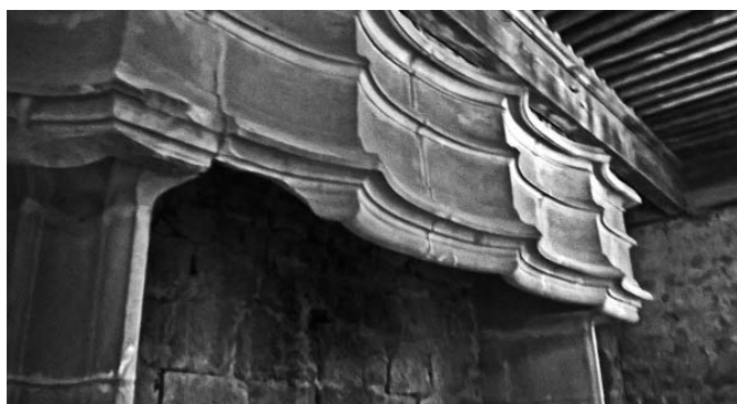
Château de Vaussèche - Cheminée du XV e siècle
