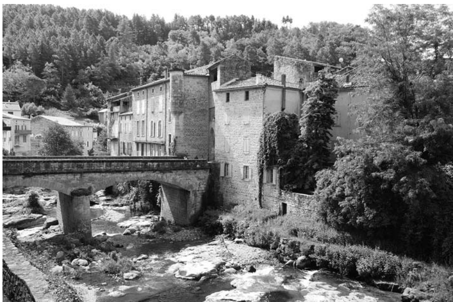
Pont des Récollets
