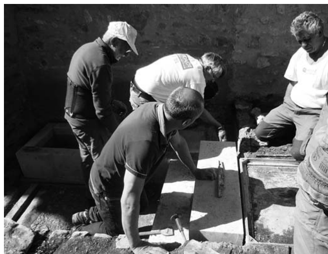
Pendant les travaux : mise à niveau des deux marches d'escalier
