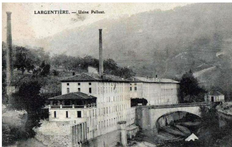
réalisée en 1886, qui assure une hauteur de chute allant jusqu'à 10 mètres pour la roue du bâtiment amont, 14 mètres pour la roue aval. Mais la vapeur peut au moins suppléer partiellement au manque d'eau lors des « à-sec », et c'est probablement dans la période de 1870 à 1890 que
