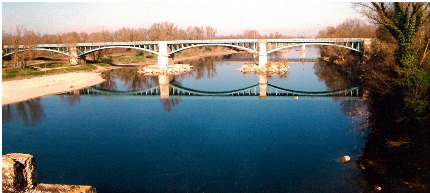
Le nouveau pont (pont actuel sur la RD 86) en 1998 (Alain Fambon)
